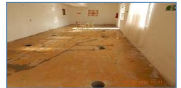
Trabajos de prospecciones en Módulo 71, Área 10, para verificar magnitud de socavamiento bajo losa
